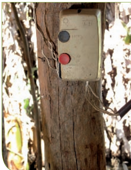
Instalação elétrica mal feita
