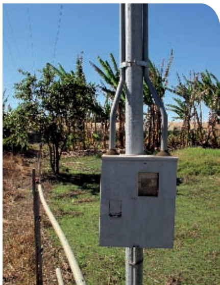
Instalação elétrica bem feita
